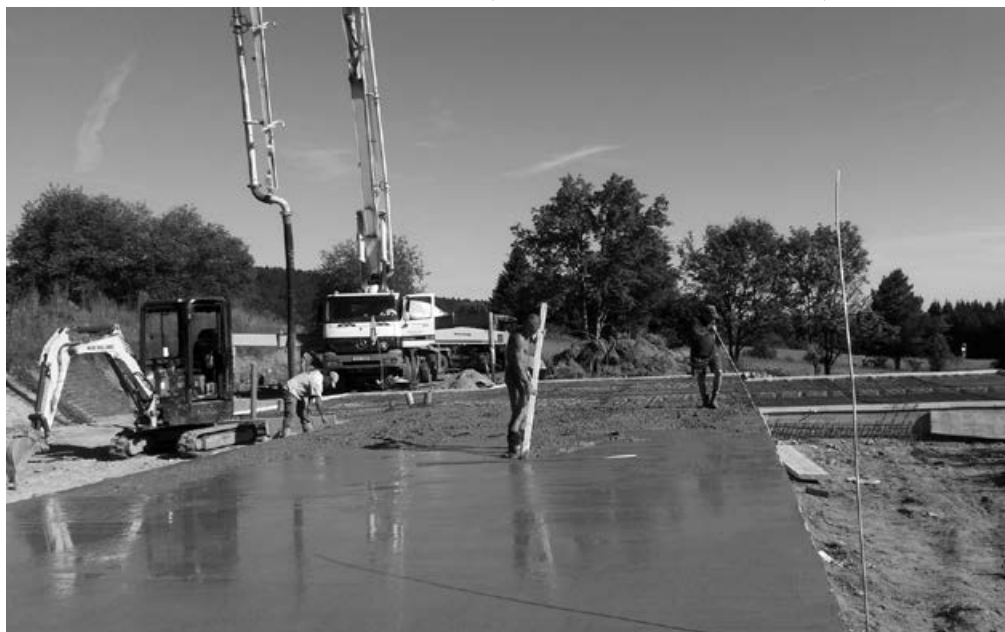
Obrázek 2 Dokončování povrchu základové desky po nalití betonu (zdroj: Autojeřáby Kladno, s. r. o.)
